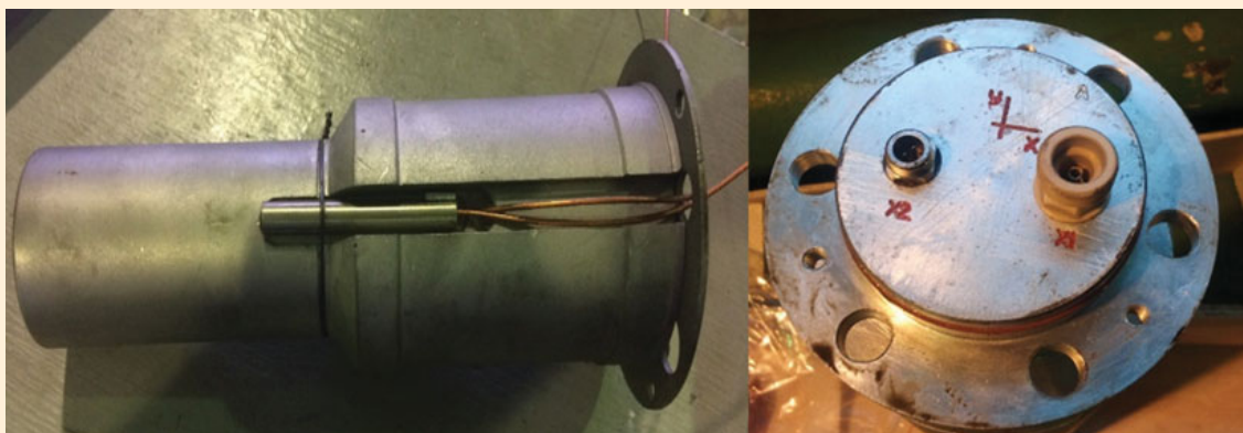
Рис. 4. Установка датчиков температуры в СПТП Завода 1
