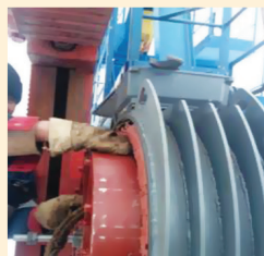
Рис.7 Последовательность монтажа бестрансмиссионного привода редуктора станка-качалки
